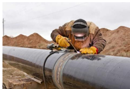
Şəkil 12. Qaynaq işlərindən əvvəl borunun kənarının hazırlanma prosesi.
