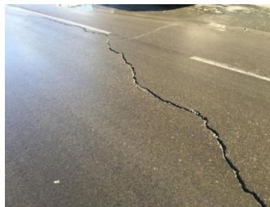
Şəkil 1. Torpaq yatağının qabarması nəticəsində yol geyiminin deformasiyaları.
