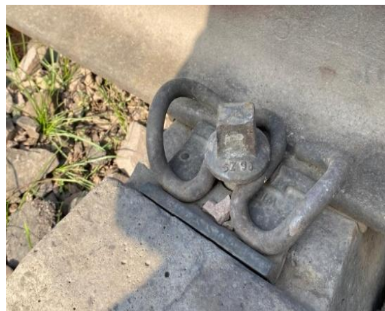
Рис 4.Скрепление SKL14 в Казахстане [8]
