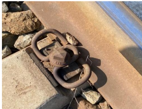
Рис. 3.Скрепление SKL14 в Азербайджане [7]
