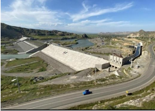
Şəkil 8. Qız qalası hidroqovşağı
