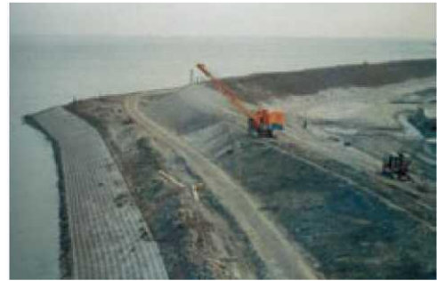
Şəkil 2. Texel (Hollandiya) yaxınlığında fırtınanın yaratdığı eroziyası və mühafizə bəndinin tikintisi.
