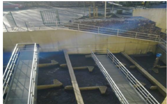
Şəkil. 1 Hengstsee su anbarının ümumi görünüşü və balıqburaxan qurğusu.
